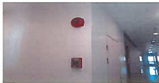
กริ่งสัญญาณเตือนภัย เครื่องแจ้งเหตุโดยใช้นมือดึง
