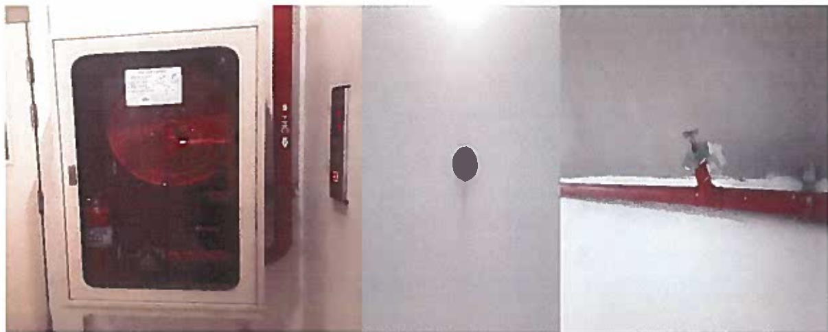
ตู้เก็บสายฉีดดับเพลิงพร้อมอุปกรณ์
